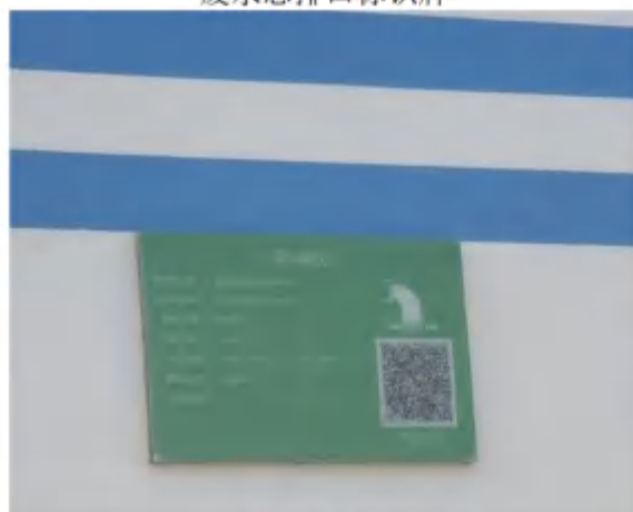
雨水排放口标识牌
