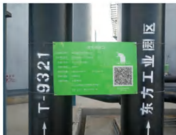
废水总排口标识牌
