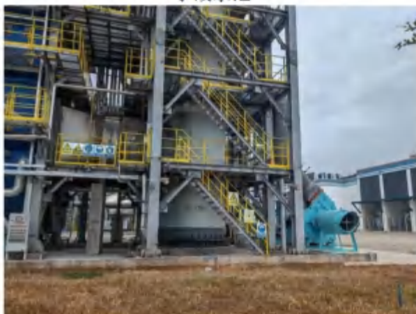
DPC 装置区围堰
