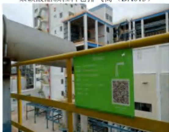
聚碳酸酯颗粒料仓排气筒（DA015）标识牌
